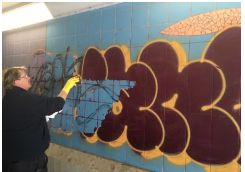
Graffitentfernung Personenunterführung Brüggli
