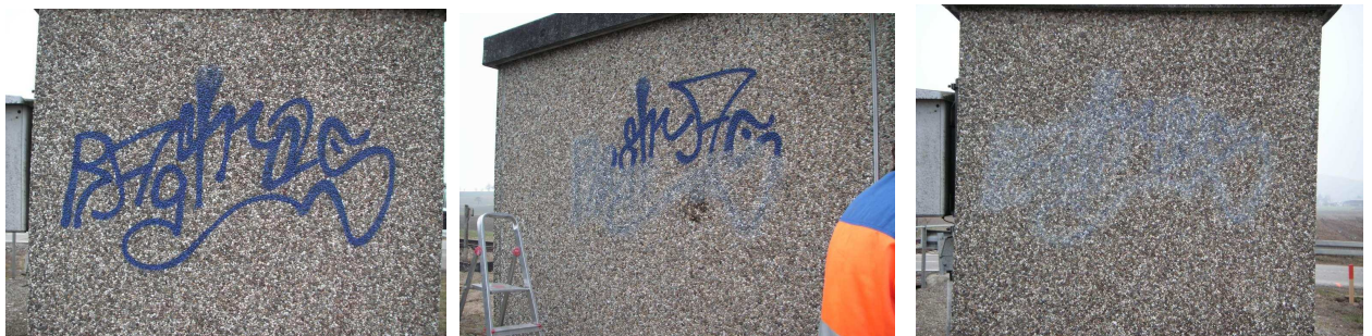
Vorher - nachher: DB Trafo-Station in Beringen
